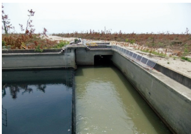
放流ゲートの撤去による一次放流ルートの確保
