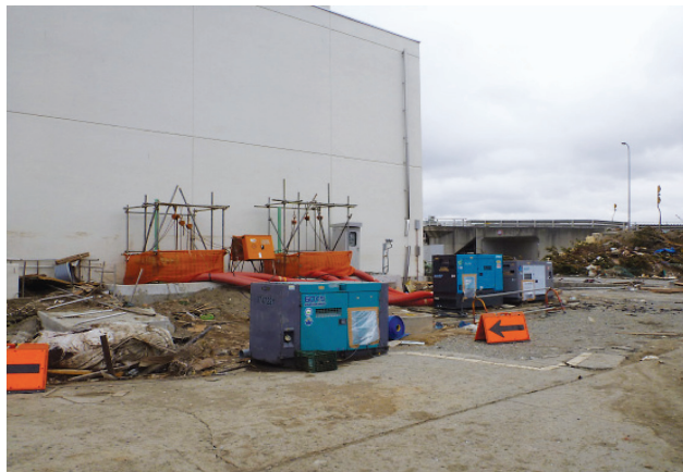
仮設発電機の設置状況
