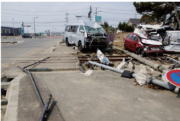
市街地の電柱が津波で倒壊
