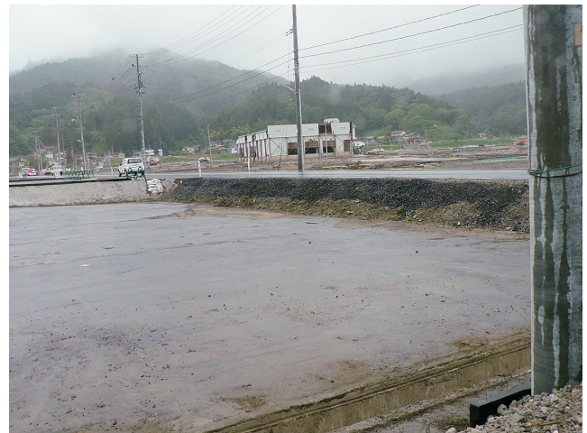
かさ上げされた道路は高いところで1m近くにもなる
