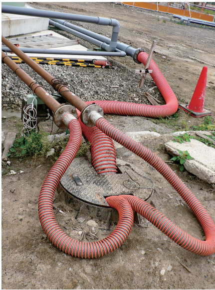
公園の敷地内のマンホールから下水を揚水
