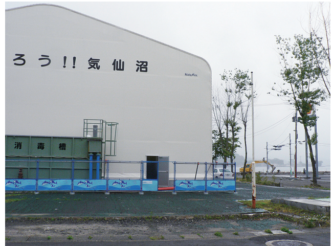
港町の施設はテント式の建屋構造になっている
