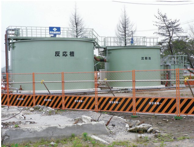
内の脇（大川公園）に建設された仮設処理施設
