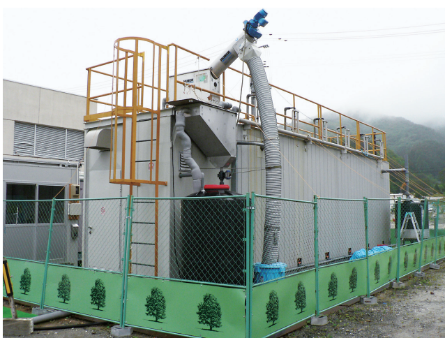
鹿折（中みなと町）の鹿折中継ポンプ場に設置された多段式生物処理装置MSABP
