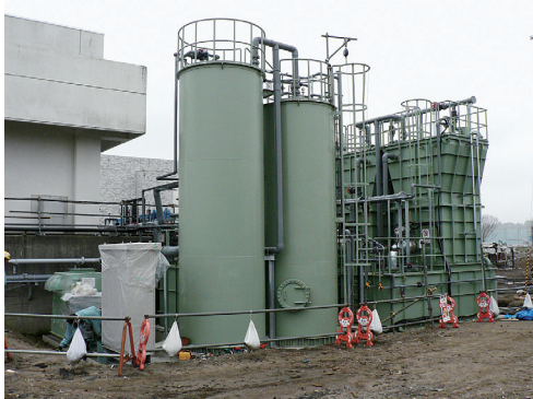
設置が完了した気仙沼終末処理場の仮設処理施設
