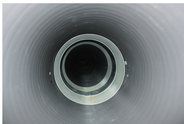
美しく仕上がった内部
