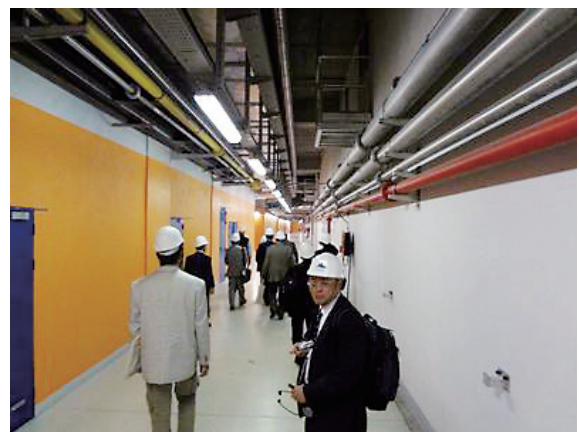
ジオライト下水処理場視察
