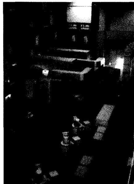
写真-1 設置状況
