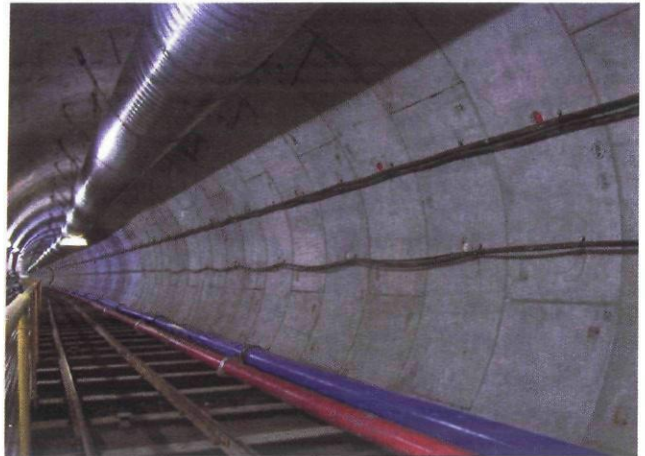
(2) 鋼管挿入式継手型セグメント
