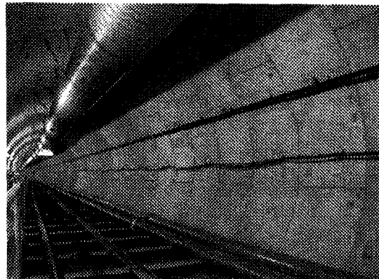
(2)鋼管挿入式継手型セグメント
