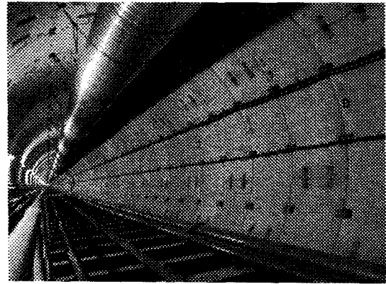
(1)ボルト継手型セグメント
