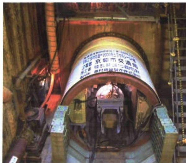
写真-1 シールド機による切羽圧力保持状況
