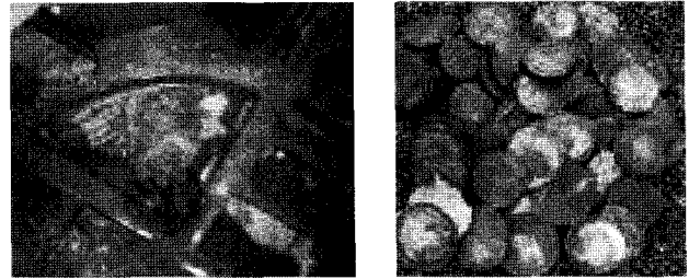
写真-5 実証施工時の切削の様子と切削片
