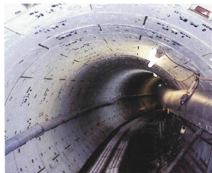
写真-3 実証施工状況
