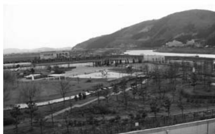
写真-4 日野川浄化センター
