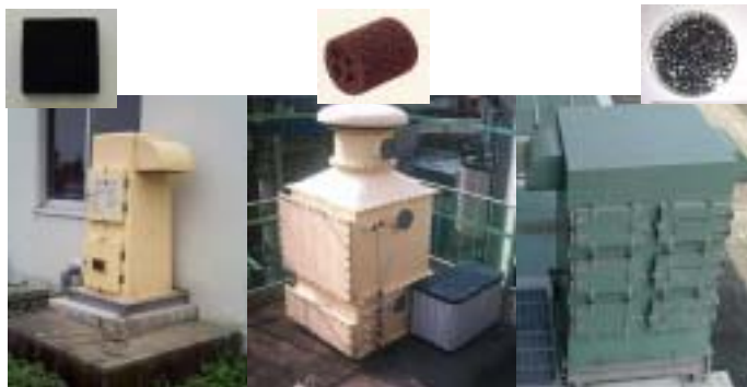
ハニカム活性炭簡易脱臭装置 マカロニ十字炭簡易脱臭装置 活性炭フィルター簡易脱臭装置
