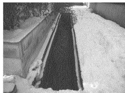
図-2 既存水路状況
