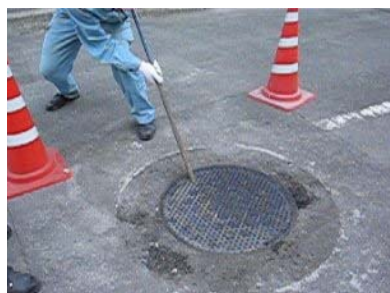
図－12 開閉機器以外の工具による開ふた確認状況
