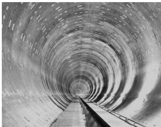
写真 大深度雨水貯留管きょ内の全景
