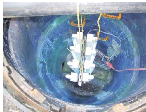
写真-2 シート硬化（紫外線照射工）
