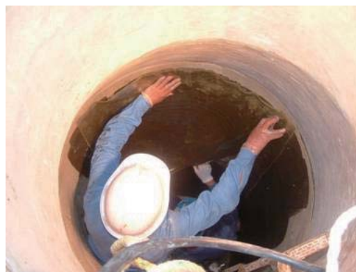
写真-1 PPSシート貼り付け工
