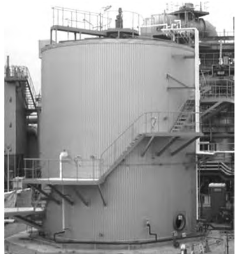
写真-1 実証施設の外観 (平成25年4月撤去)
