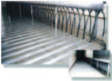
メンブレン式散気装置
