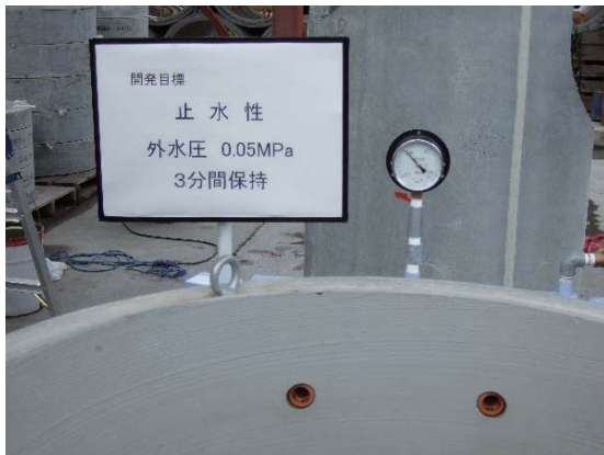
写真-2 水圧試験状況
