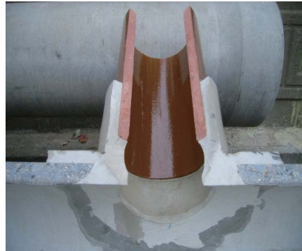
写真一 2 30 mm隙間・内面仕上げ状況
