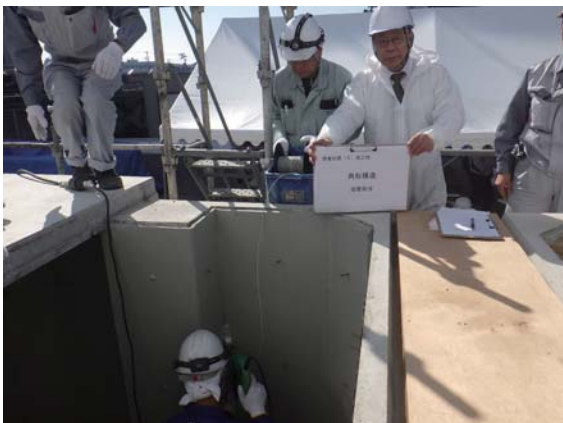
写真-1 立会試験での施工状況
