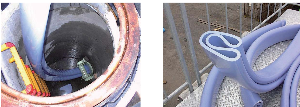
写真-1 オメガライナー工法
