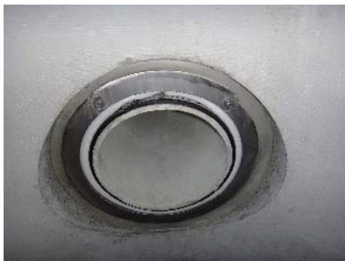
写真-3 耐震可とう継手設置状況
