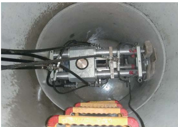
写真-2 切削状況
