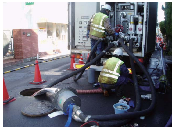
写真-1 施工状況（温水硬化）
