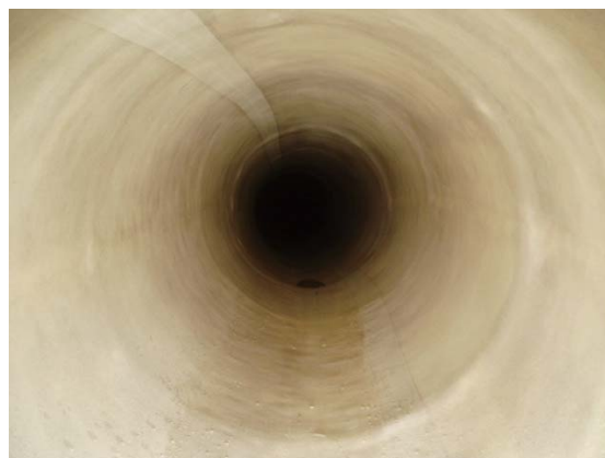
写真-2 施工後管内状況
