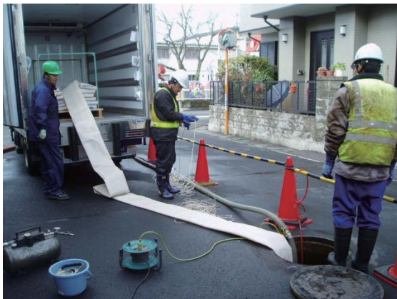
写真-1 施工状況（温水硬化）
