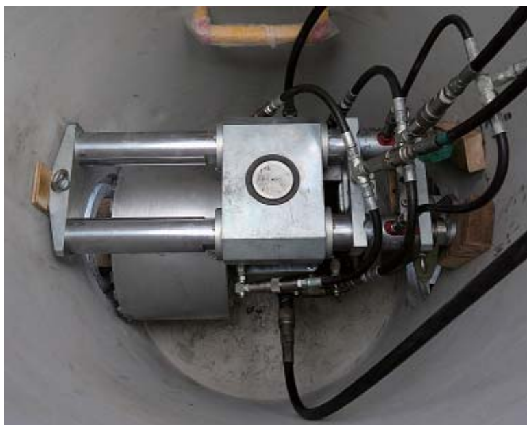
写真—1 切削機設置状況
