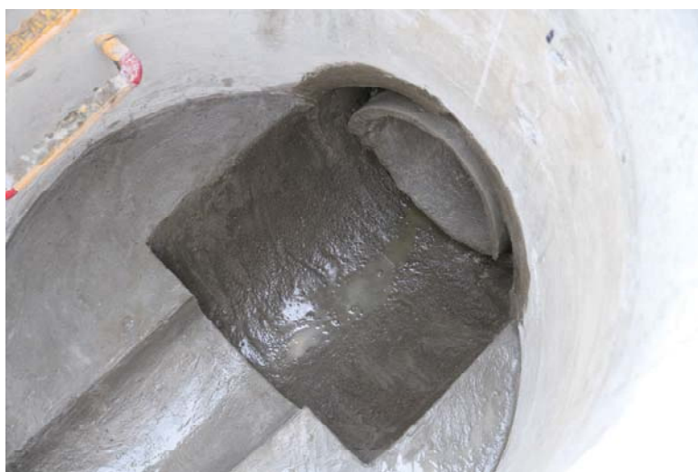
写真—2 切削完了状況
