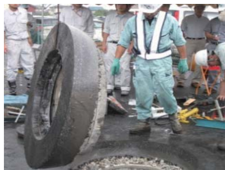
写真－2 切断塊の吊上げ
