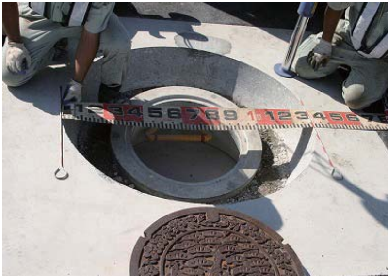
写真-3 立会試験での円形球面切断状況
