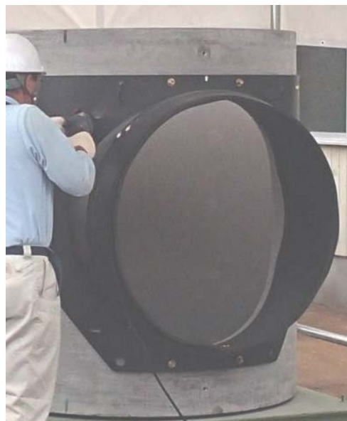
写真-2 WIDEジョイントの取り付け状況
