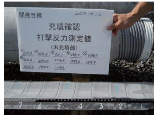
写真－3 複合管充てん確認状況
