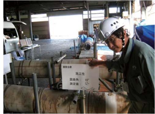
写真－1 施工性確認状況
