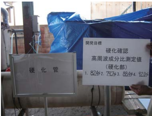
写真－2 CIPP 硬化確認状況
