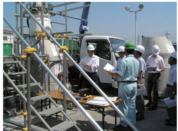
写真1 施工性の確認試験状況
