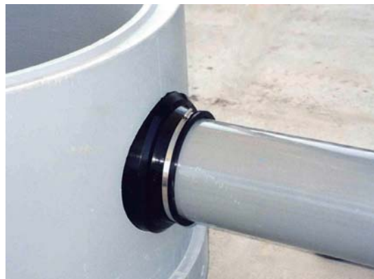
写真-1 装着したNCラバーコーン
