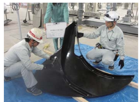
写真-1 II型攪拌翼の組立作業
