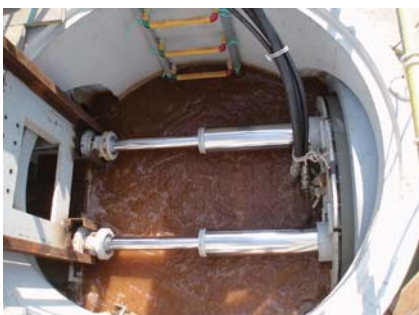
写真－4 推進完了
