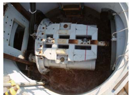
写真－6 推進装置回収
