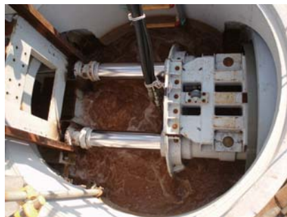
写真－5 推進装置引戻し
