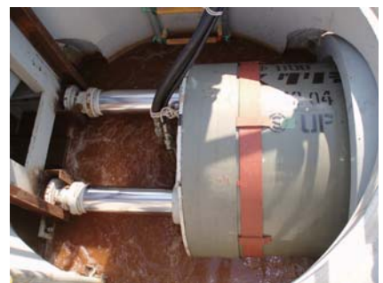
写真－3 推進状況
