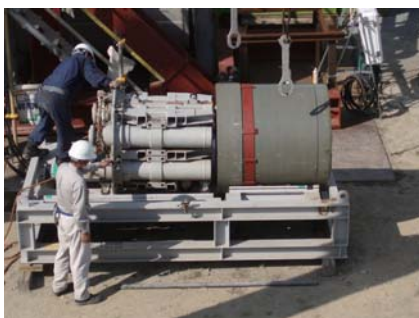
写真－1 推進装置挿入
