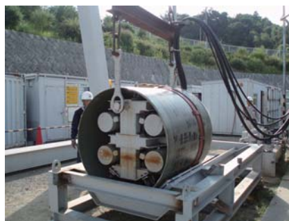
写真－2 推進装置挿入完了
