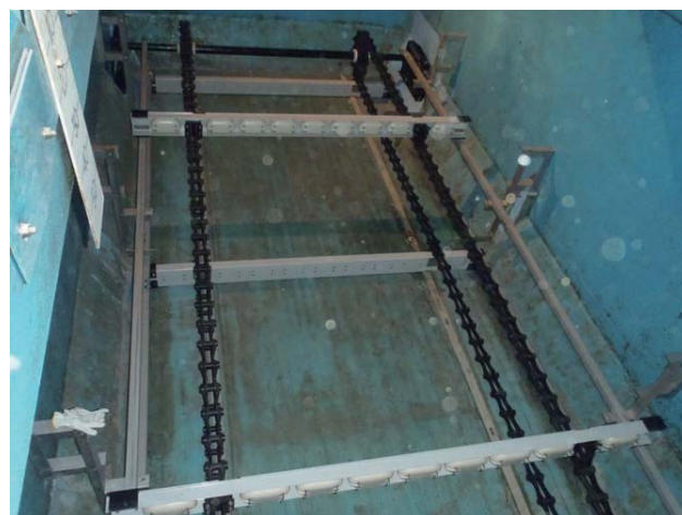
写真－2 浮上型チェーンフライント式 汚泥かき寄せ機実機据付2
