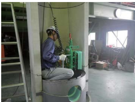
写真-3 樹脂セグメントの設置状況
