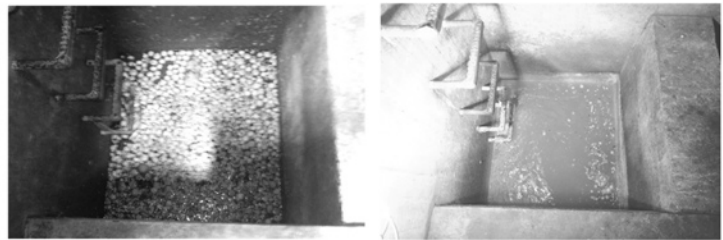
フラッシュゲート設置前の伏越し室内の状況
