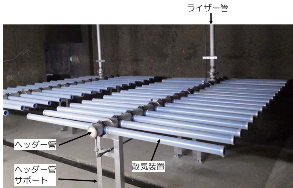
写真－２ 散気装置の据付状態（標準槽・旋回流式の例）
