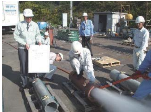
写真-4 高压洗浄試験状況
