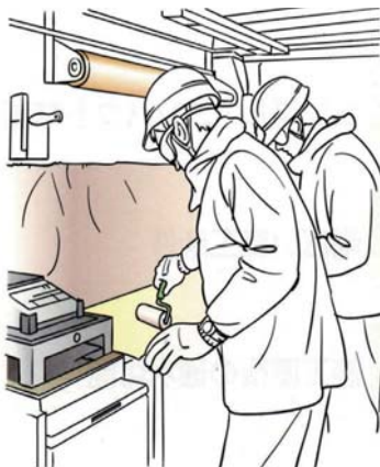
図-3 施工状況（樹脂含浸）
