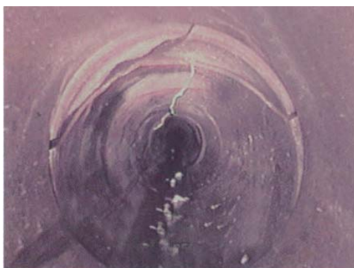
写真-1 施工前管内状況
