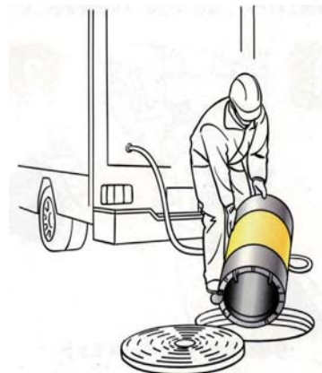
図-4 施工状況（補修機導入）
