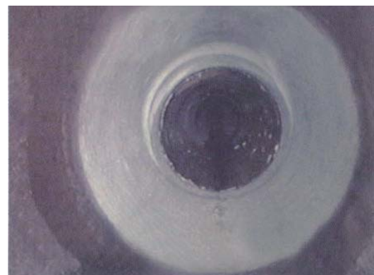
写真-2 施工後管内状況
